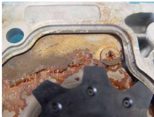
Corrosión de la placa inferior
